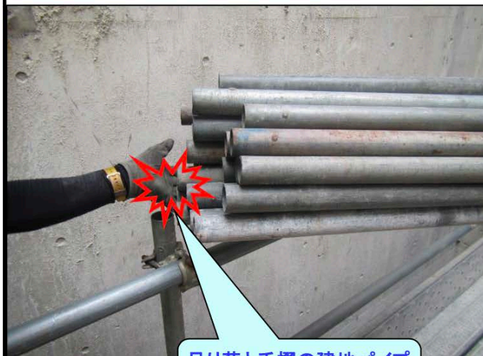
吊り荷と手摺りの建地パイプに挟まれる
